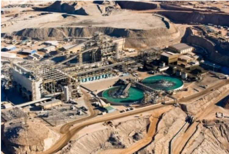
Operaciones de la Expansión de la Unidad de Producción de Cerro Verde
