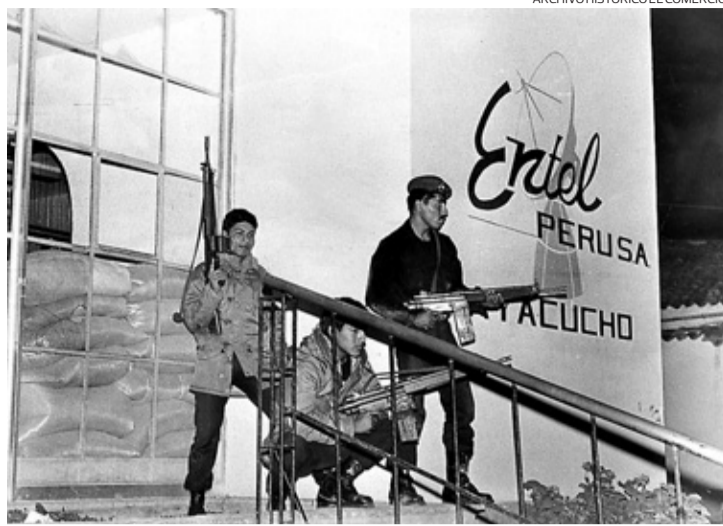
TERRORISMO. Voladura de estación de alta tensión de Entel Perú.
